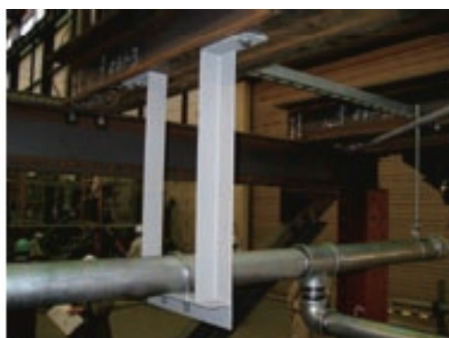
図-1 A種耐震振止め
