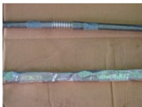
図-6 巻き出し配管の鉛巻き
