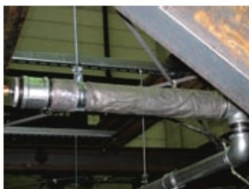
図-5 配管の鉛巻き
