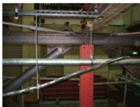
図-4 巻き出し配管の中間支持
