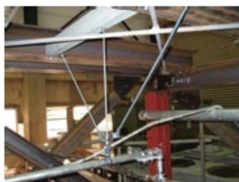
図-2 B種耐震振止め
